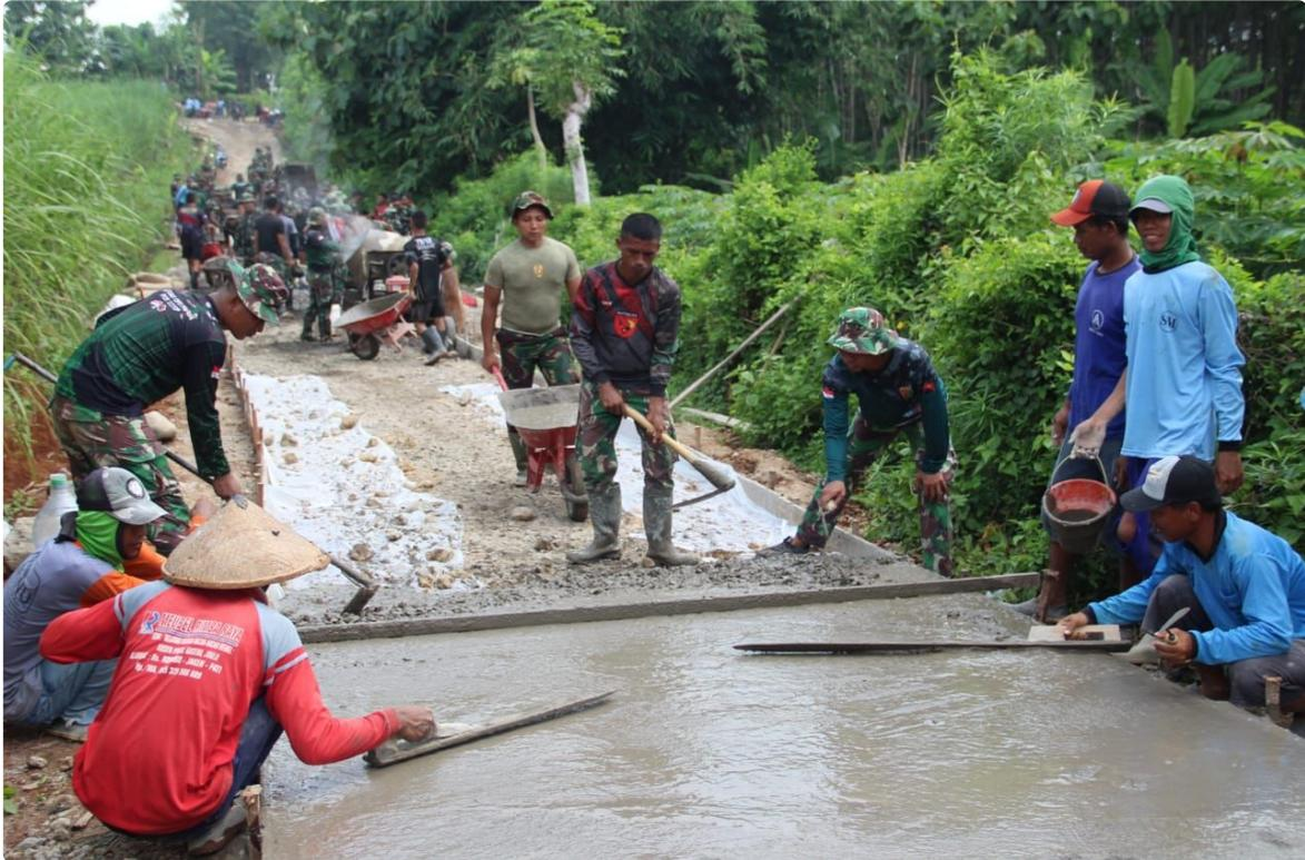
Progres betonisasi sektor pertama jalan ukuran 586 X 3 X 0,15 M pencapaian 540 Meter/ 92,1 %, betonisasi sektor kedua jalan ukuran 525 X 2,5 X 0,15 M pencapaian 320 Meter/ 60,9 % sedangkan sektor ketiga jalan ukuran 357 X 4 X 0,15 M menunggu giliran dikerjakan.
